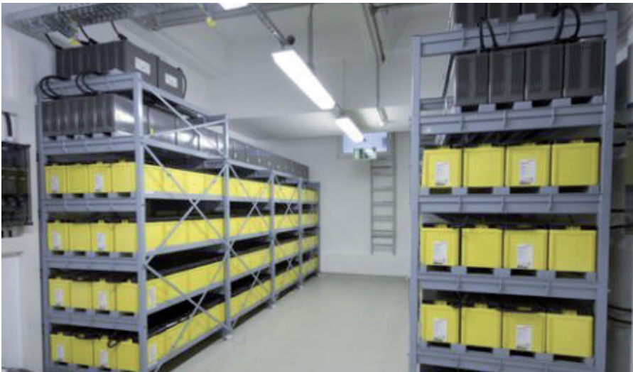
Getrennte Batteriestränge für sofortige Stromversorgung
